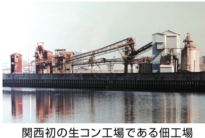
関西初の生コン工場である佃工場
